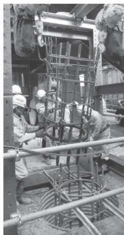
(杭配筋の分割施工)
