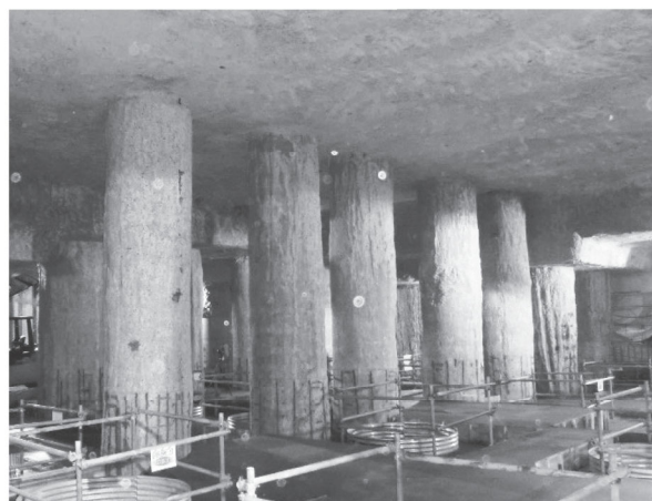
写真3 既存杭（掘削後、新設杭施工前）
